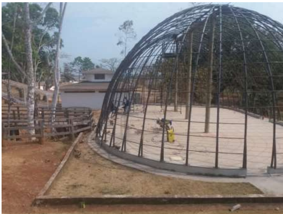
Figura 30– Construção da oca. Foto: Andreia Ravani.
