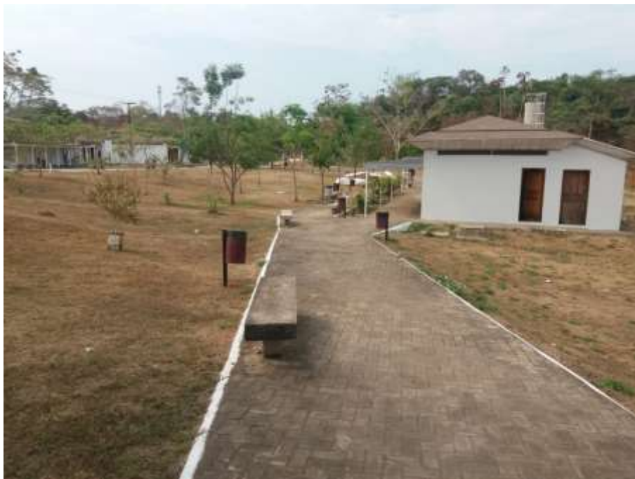
Figura 5– Vista da entrada e das obras realizadas. Foto: Andreia Ravani.
