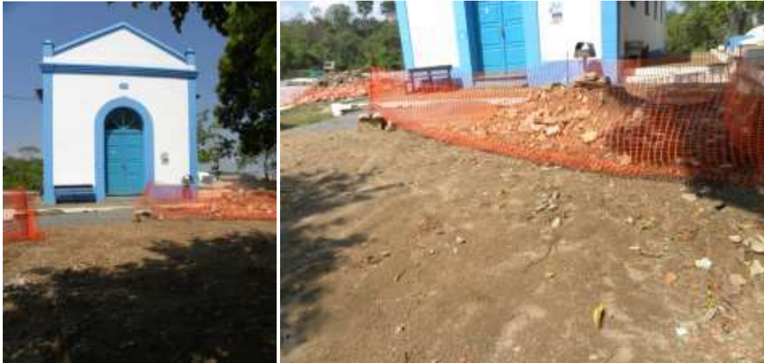
Figura 17- Retirada do calçamento da frente da Igrejinha da Vila de Santo Antônio, Fonte: Scientia (2012).
