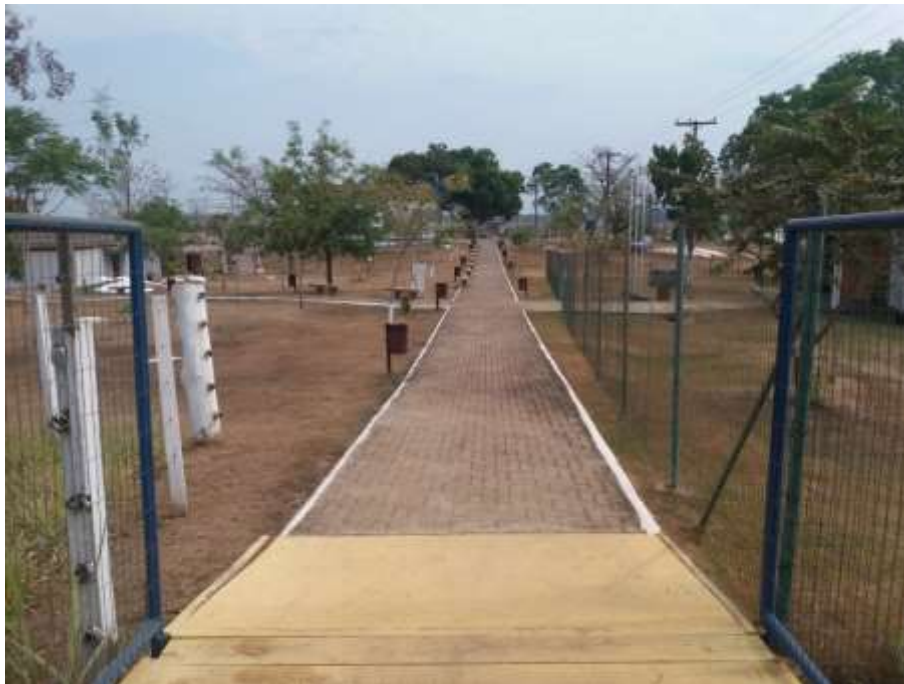
Figura 3- Entrada após as obras de recuperação e revitalização. Foto: Andrea Ravani.
