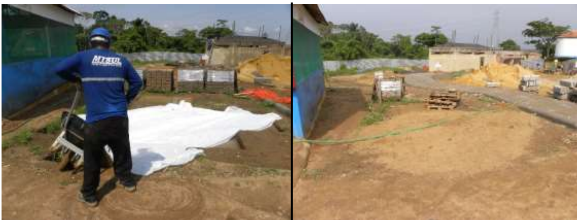
Figura 9 – Cobertura do piso antigo com TNT e areia grossa lavada respectivamente. Foto: Ney Gomes.
